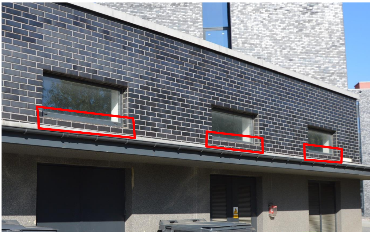
Rys. nr 40. Elewacja południowa budynku gospodarczego. Brak podokienników zewnętrznych w oknach (ryzyko wnikania wody opadowej do wewnętrznej struktury ścian zewnętrznych budynku gospodarczego) – nieprawidłowość oznaczona na mapie uszkodzeń jako G11 [1.2].
