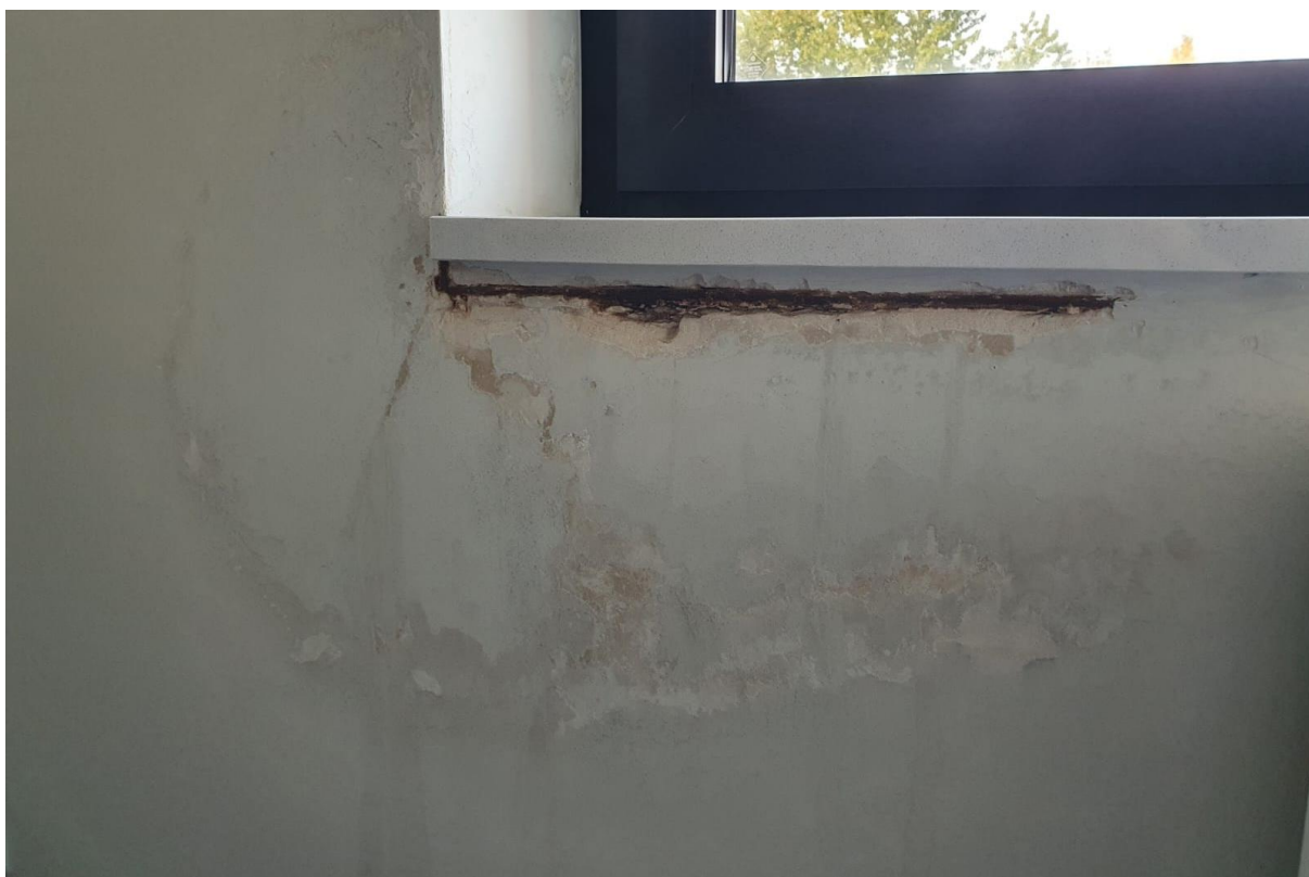
Rys. nr 53. Odparzenia tynku wewnętrznego w ścianie zewnętrznej w pomieszczeniu nr 2.15 (budynek Sądu Rejonowego) [1.2].
