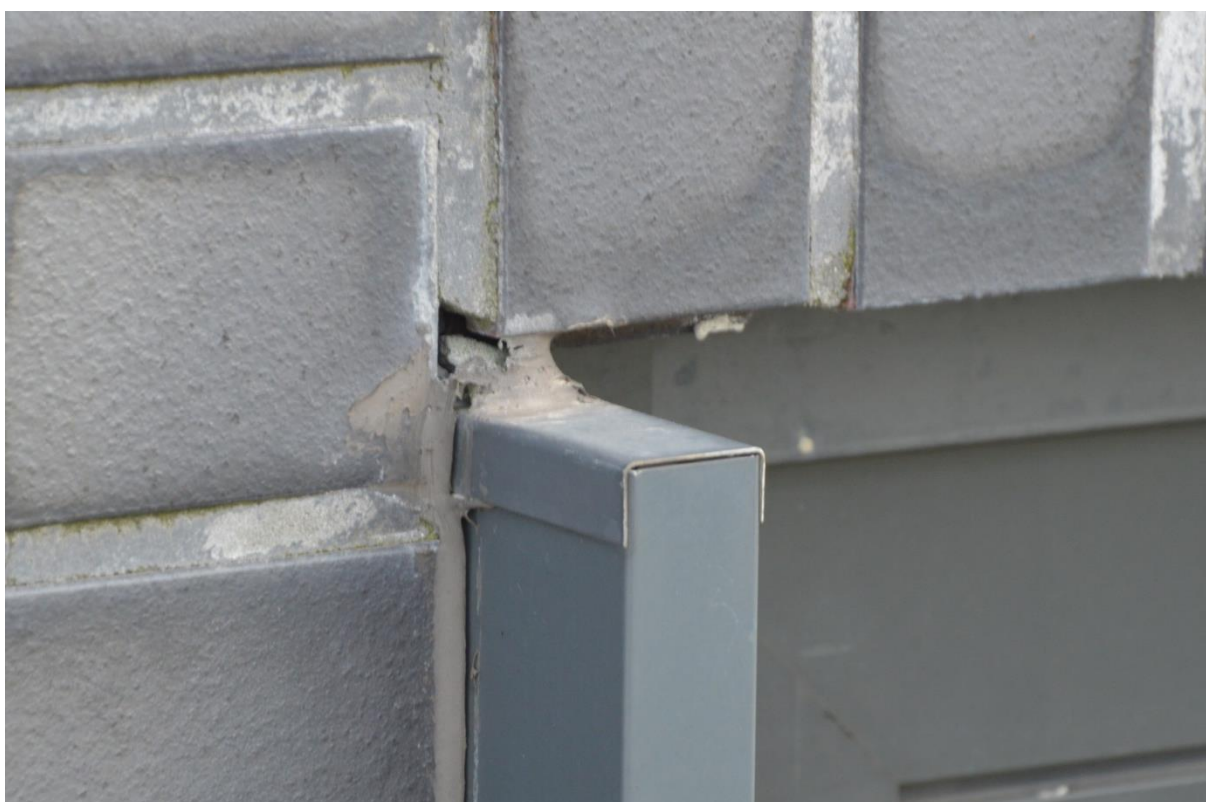
Rys. nr 22. Wadliwe uszczelnienie połączenia górnej krawędzi słupka fasady aluminiowej z systemem INFATEC. Oddzielenie się masy silikonowej od pionowej ścianki słupka (nieszczelność na pionowym styku systemu INFATEC z fasadą aluminiową) [1.2].
