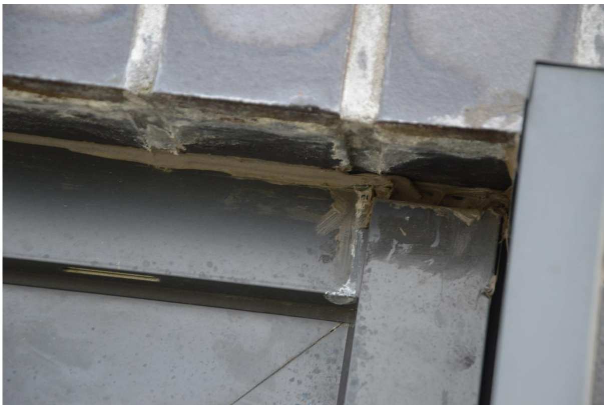
Rys. nr 23. Wadliwe uszczelnienie górnej ramy okna z nadprożem [1.2].
