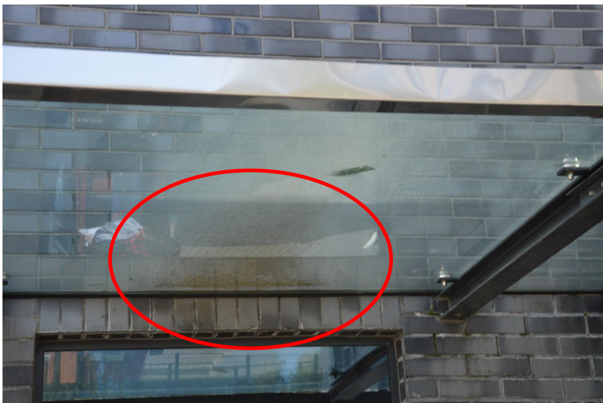
Rys. nr 47. Zadaszenie nad zejściem do poziomu piwnic w budynku Sądu Rejonowego od strony elewacji SE. Osad powstały przy elewacji wskazuje na wadliwy spadek zadaszenia we wskazanym miejscu (woda opadowa spływa w kierunku budynku) [1.2.].
