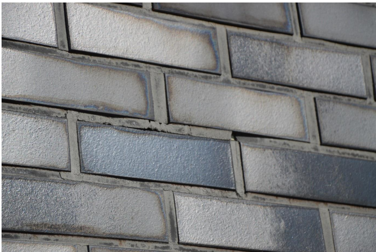
Rys. nr 27. Spoiny w elewacjach INFATEC nie licują się z płytkami klinkierowymi, widoczne odsłonięcie krawędzi bocznych płytek. Na powyższym zdjęciu spoiny wykazują lokalnie ubytki oraz uszkodzenia mechaniczne [1.2].
