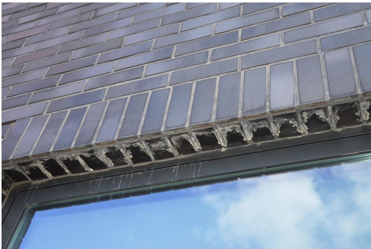
Rys. nr 20. Tworzenie się wykwitów solnych w obrębie nadproża. Lokalnie zacieki solne powodują zanieczyszczenie okien (sole budowlane ściekają na ramy okienne i przeszklenie) [1.2].
