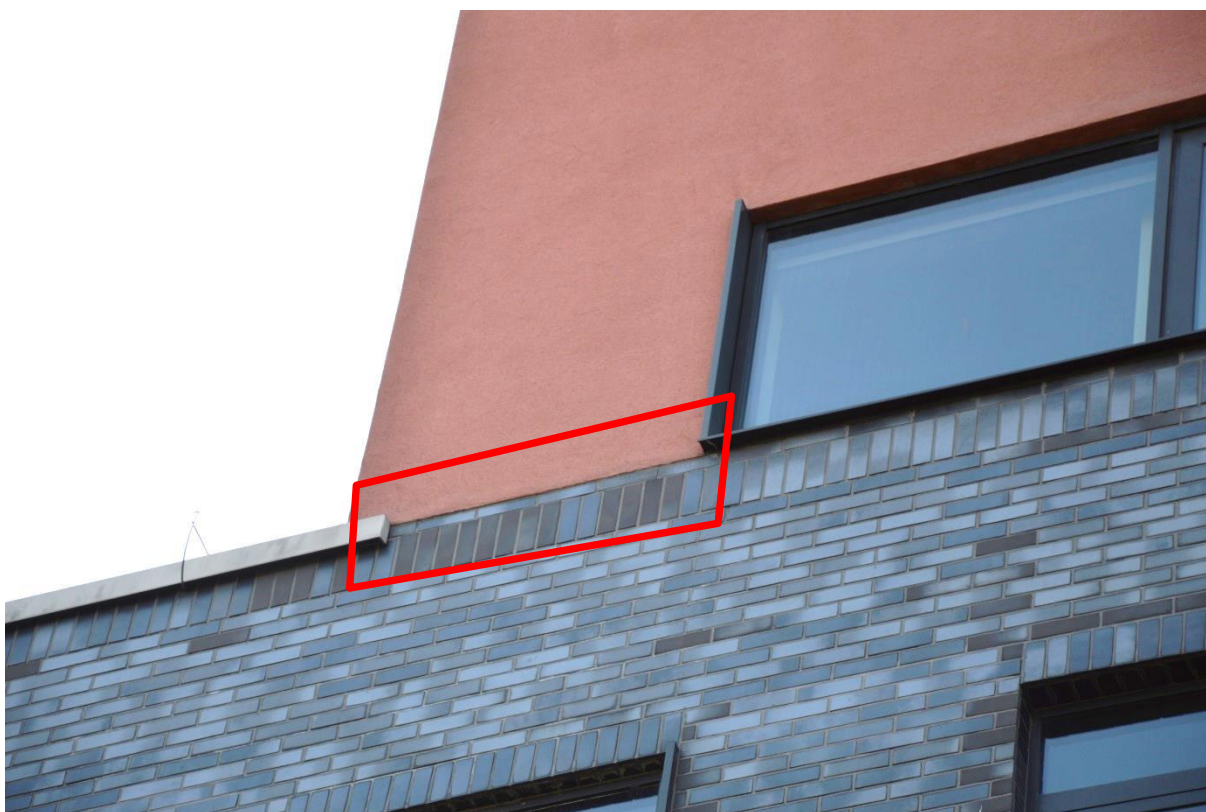
Rys. nr 38. Poziomy styk elewacji INFATEC z ociepleniem ETICS bez stosownego zabezpieczenia przed wnikaniem wody opadowej (elewacja podłużna NE segmentu nr 6) – nieprawidłowość oznaczona na mapie uszkodzeń jako E1 [1.2.].
