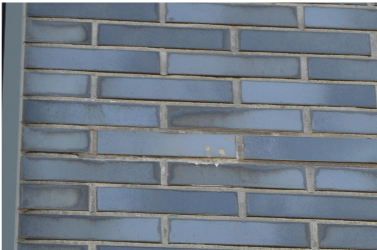
Rys. nr 26. Spoiny w elewacjach INFATEC nie licują się z płytkami klinkierowymi, widoczne odsłonięcie krawędzi bocznych płytek [1.2.].
