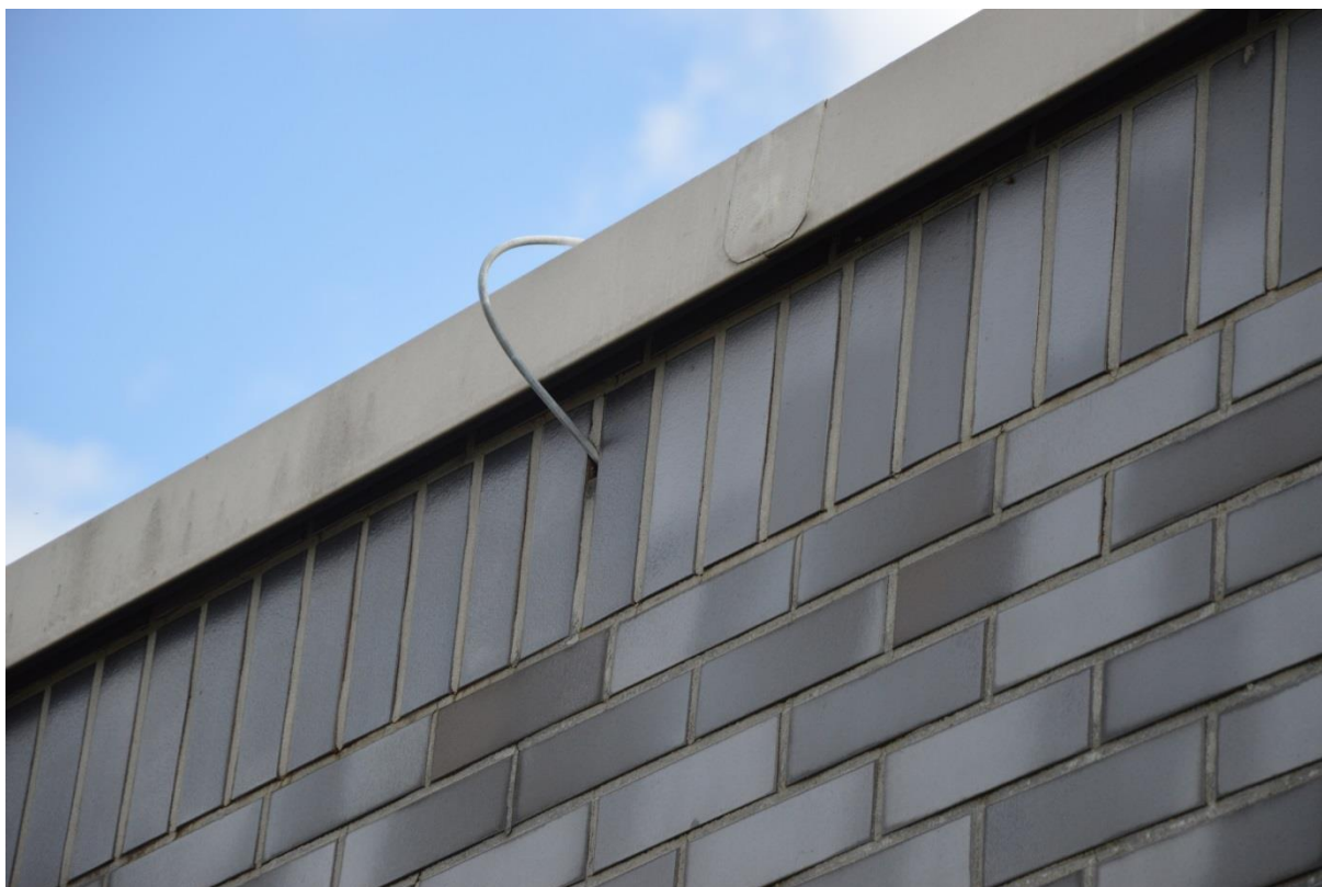
Rys. nr 29. Przebicie elewacji INFATEC przez przewód odprowadzający instalacji odgromowej. Rozwiązanie sprzyjające wnikanii wody opadowej do wewnętrznej struktury ocieplenia. Brak jakiegokolwiek uszczelnienia przejścia instalacji odgromowej w elewacji [1.2.].
