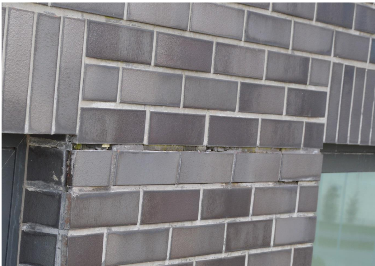
Rys. nr 31. Przykład ubytków masy fugowej w spoinach poziomych pomiędzy oknami (elewacja NW) – nieprawidłowość oznaczona na mapie uszkodzeń jako A38 [1.2].
