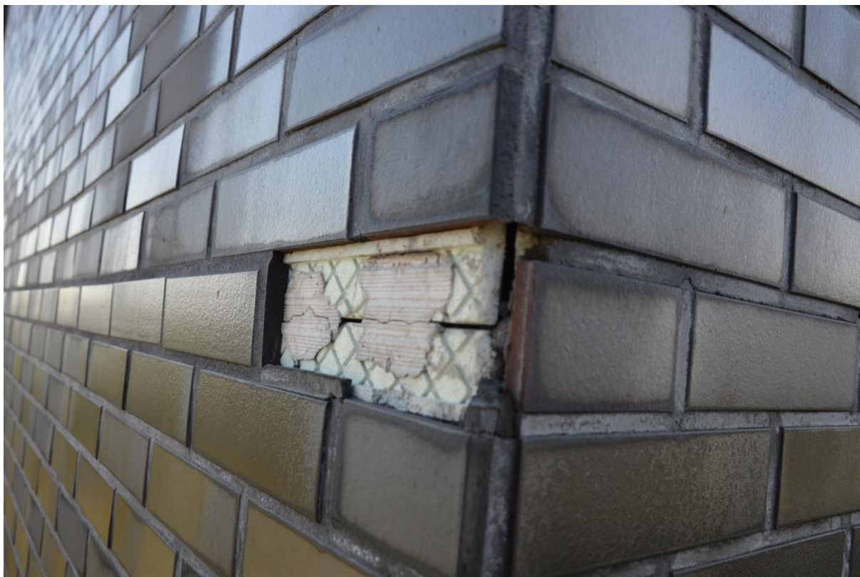
Rys. nr 34. Ubytek płytki klinkierowej (zachodni kraniec elewacji szczytowej NE) – nieprawidłowość oznaczona na mapie uszkodzeń jako C1. Ślady zaprawy klejowej na styropianie wskazują na wadliwe (niezgodne z wytycznymi systemodawcy) klejenie płytek klinkierowych (klej powinien wypełniać całą przestrzeń pod płytkami klinkierowymi) [1.2].
