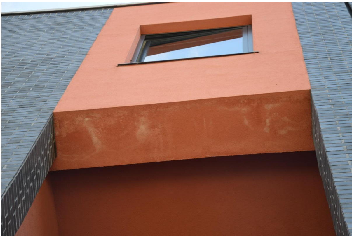
Rys. nr 44. Zacieki soli budowlanych na spodzie elementu belkowego ocieplonego w systemie ETICS zlokalizowanego we wnętrzu loggiowej (elewacja NW) [1.2.].
