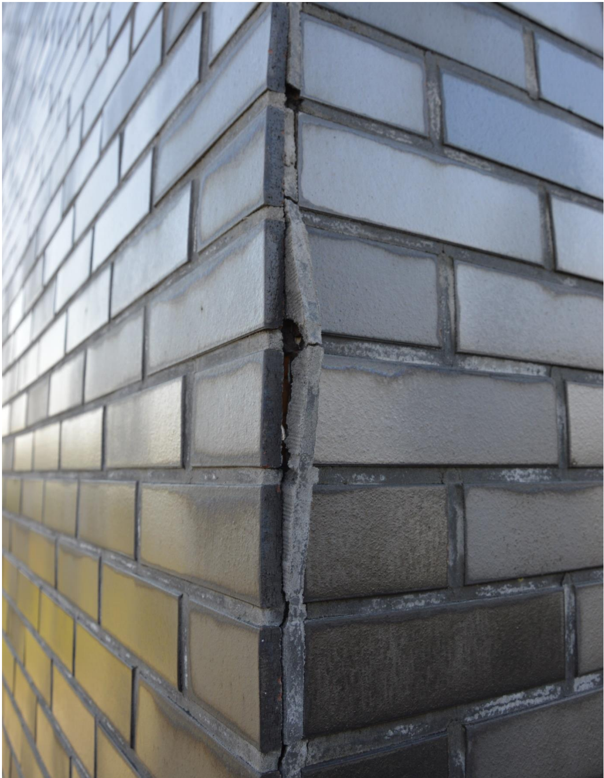
Rys. nr 30. Luźne fragmenty masy fugowej zwisające ze spoiny pionowej przy narożniku ścian (północny kraniec elewacji NW) – nieprawidłowość oznaczona na mapie uszkodzeń jako A1 [1.2].
