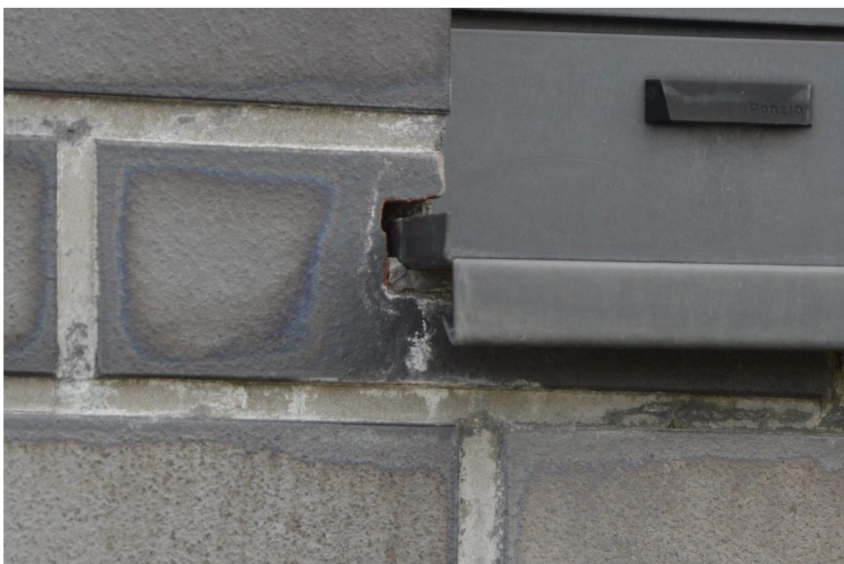
Rys. nr 24. Wadliwe połączenie podokiennika zewnętrznego z ościeżem (potencjalne miejsce migracji wody opadowej do wewnętrznej struktury ścian) [1.2].
