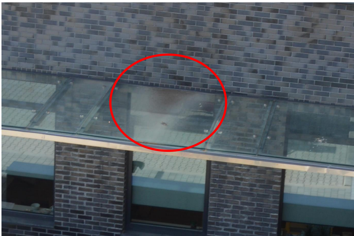
Rys. nr 46. Zadaszenie nad zejściem do poziomu piwnic w budynku Sądu Rejonowego od strony elewacji SE. Osad powstały przy elewacji wskazuje na wadliwy spadek zadaszenia we wskazanym miejscu (woda opadowa spływa w kierunku budynku) [1.2.].
