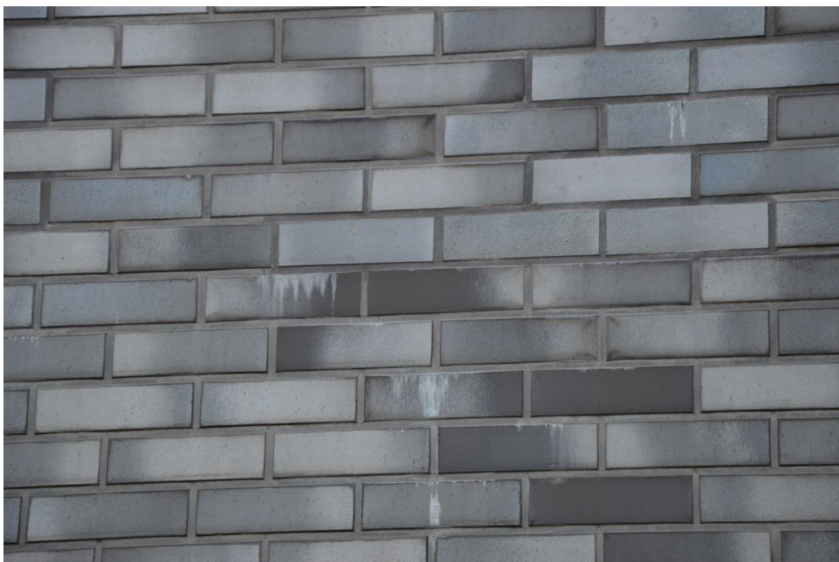
Rys. nr 36. Lokalne wykwyty soli budowlanych na elewacji INFATEC (elewacja SE) – nieprawidłowość oznaczona na mapie uszkodzeń jako B46 [1.2].
