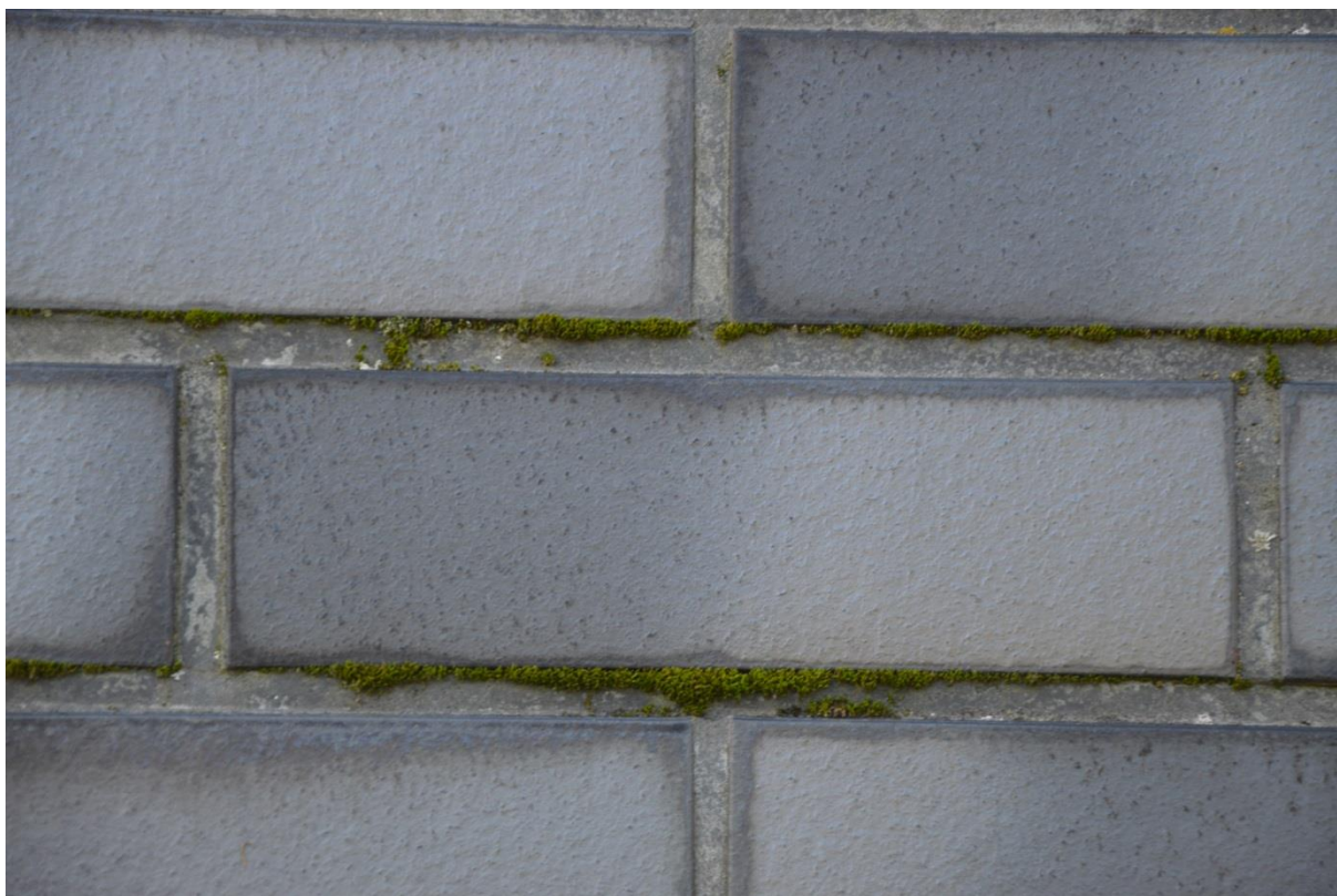
Rys. nr 35. Porost glonów w spoinach elewacji INFATEC (elewacja północna budynku gospodarczego) – nieprawidłowość oznaczona na mapie uszkodzeń jako G3 [1.2].
