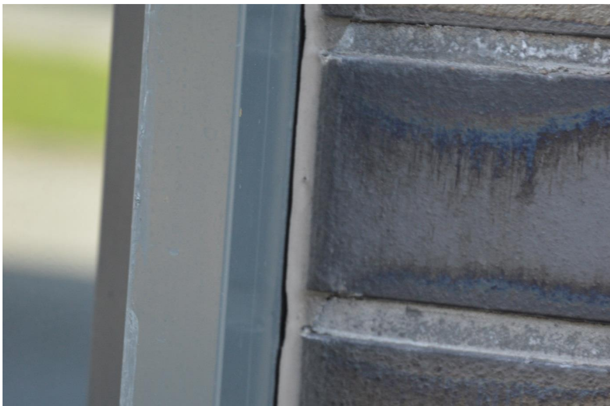
Rys. nr 25. Oddzielenie się masy silikonowej od ścianki słupka fasady aluminiowej (rozszczelnienie połączenia fasady INFATEC ze ślusarką aluminiową) [1.2.].
