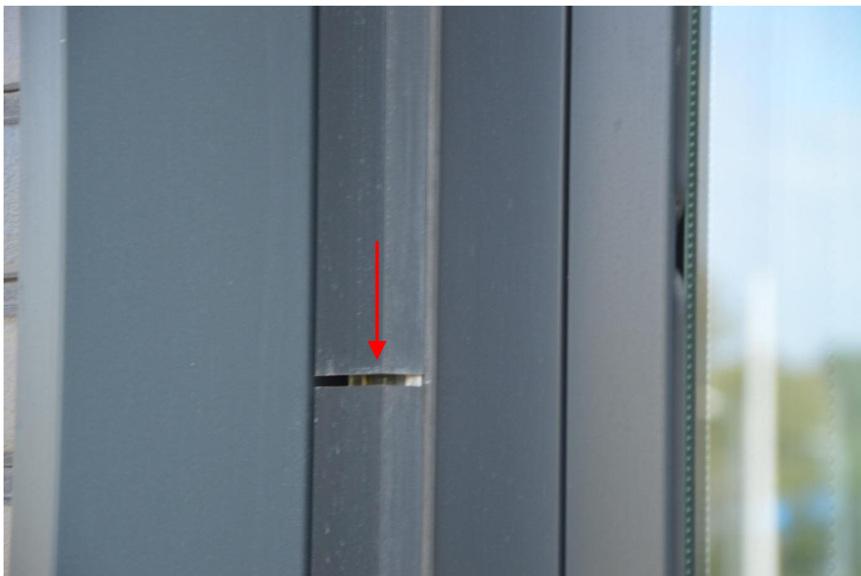
Rys. nr 49. Nieszczelność ramy fasady aluminiowej (potencjalne miejsce wnikania wody opadowej) [1.2.].
