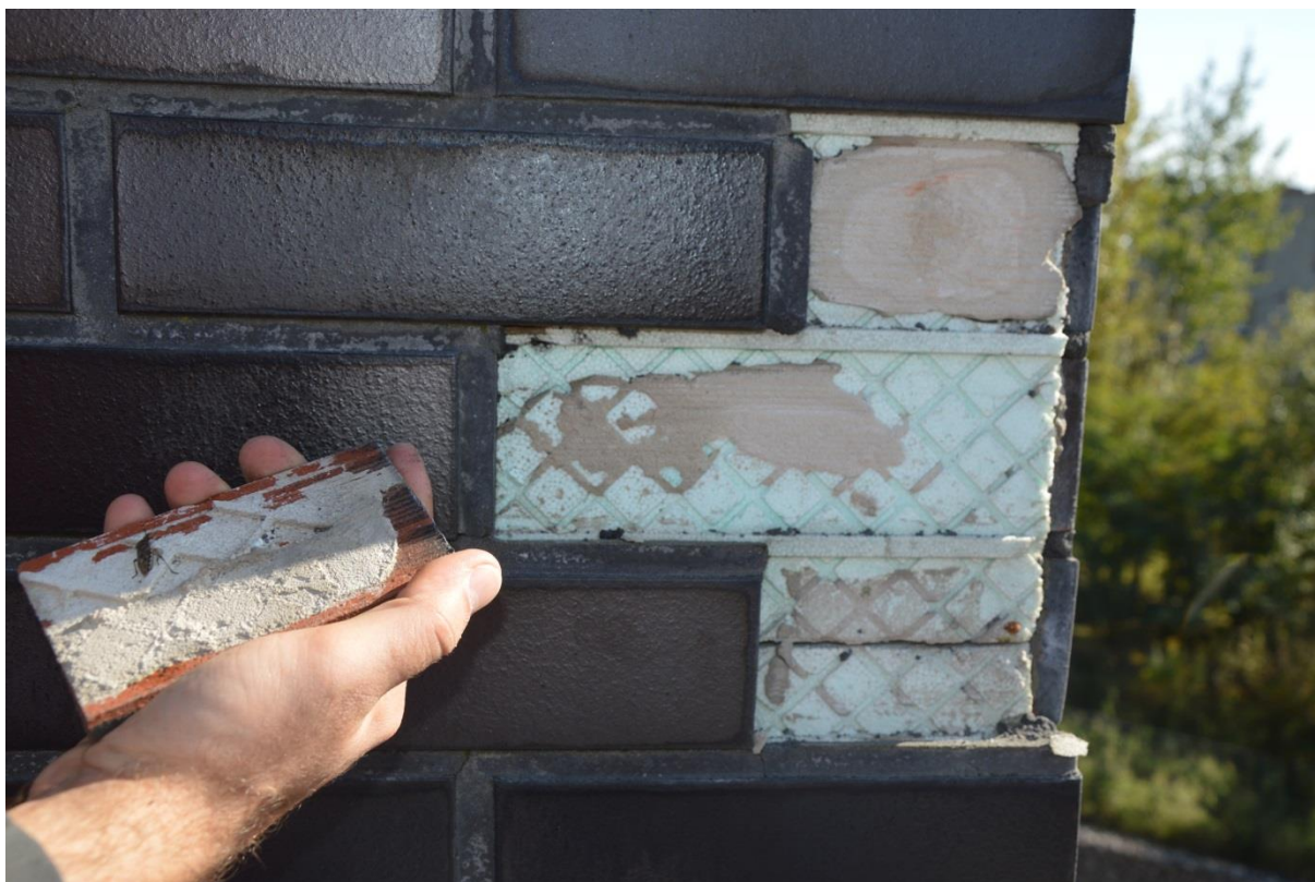
Rys. nr 33. Odspojenie się trzech płytek klinkierowych od warstwy ocieplenia (południowy kraniec elewacji NW) – nieprawidłowość oznaczona na mapie uszkodzeń jako A68. Ślady zaprawy klejowej na styropianie oraz płytce wskazują na wadliwe (niezgodne z wytycznymi systemodawcy) klejenie płytek klinkierowych (klej powinien wypełniać całą przestrzeń pod płytkami klinkierowymi) [1.2].
