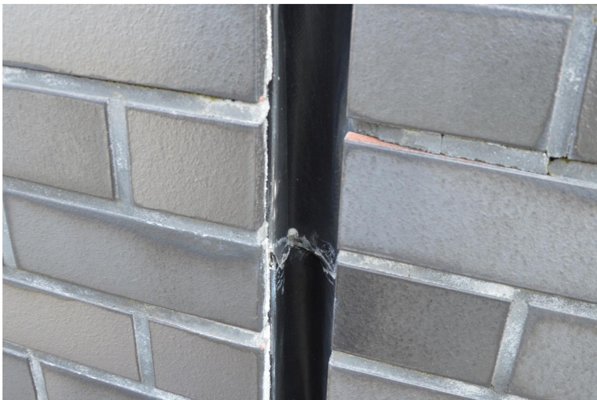
Rys. nr 28. Szczelina dylatacyjna na elewacji NW wykonana niezgodnie z dokumentacją projektową. Folia osłaniająca dylatację wchodzi pod płytki klinkierowe (ryzyko przedostawania się wody opadowej pod płytki) [1.2].
