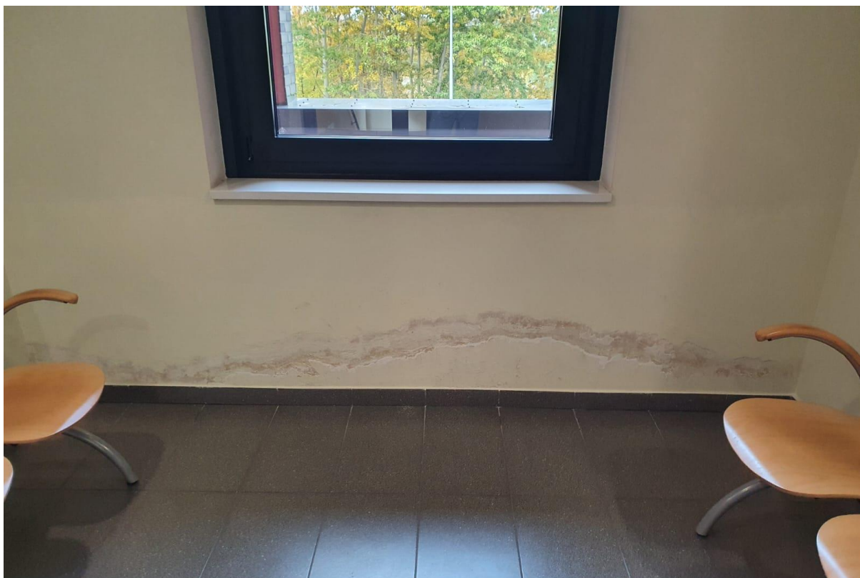
Rys. nr 54. Odparzenia tynku wewnętrznego przy powierzchni posadzki w przestrzeni komunikacyjnej budynku Sądu Rejonowego [1.2].
