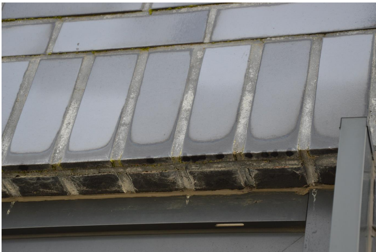
Rys. nr 19. Narożnik nadproża wykonany niezgodnie z wytycznymi systemu INFATEC oraz niezgodnie z wytycznymi dokumentacji projektowej (brak narożnych kształtek klinkierowych). Tworzenie się wykwitów solnych w obrębie nadproża [1.2].
