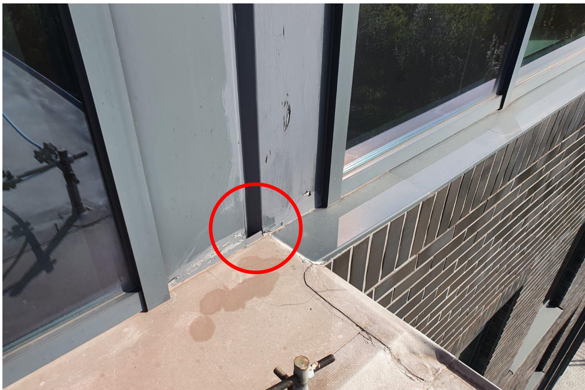
Rys. nr 51. Potencjalne miejsce wnikania wody opadowej do wnętrza budynku w miejscu połączenia obróbki dylatacji segmentów nr 3 i 6 oraz attyki segmentu nr 4 [1.2.].
