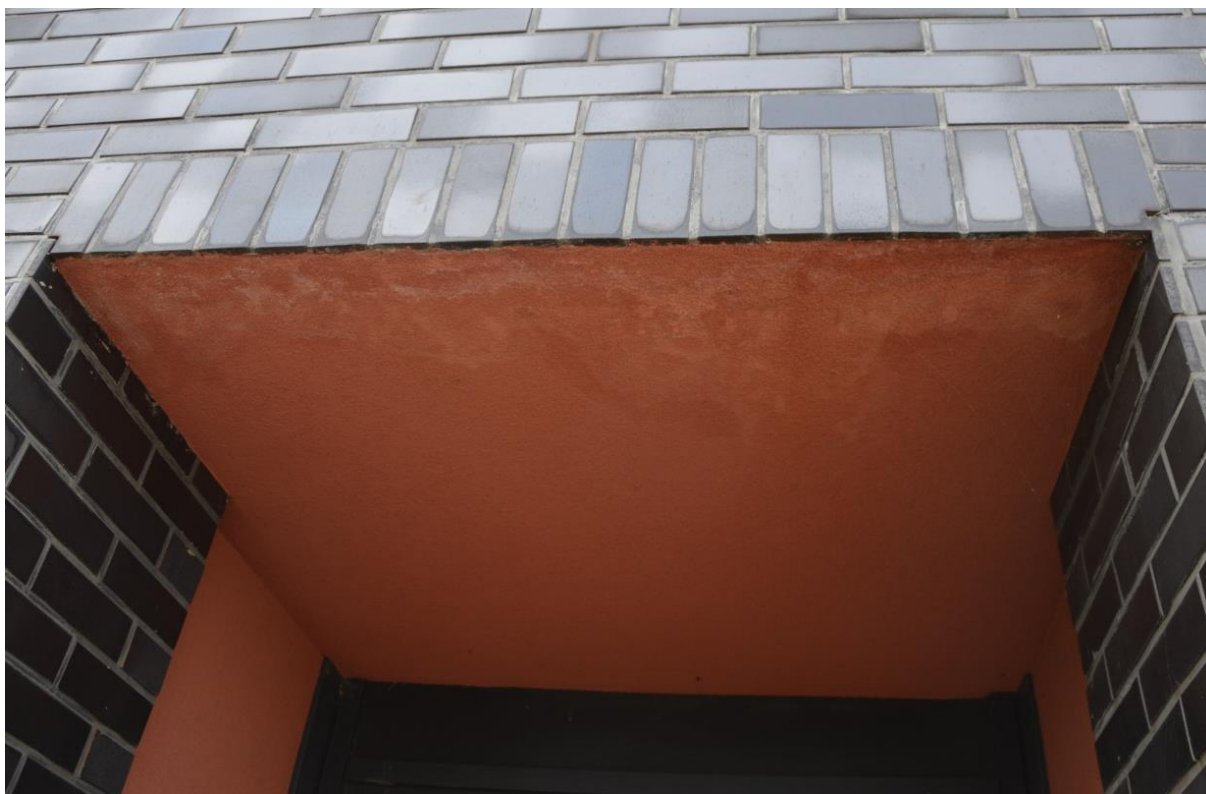
Rys. nr 42. Zacieki soli budowlanych na powierzchni stropu zewnętrznego we wnęce elewacji szczytowej NE (ocieplenie ETICS) [1.2].
