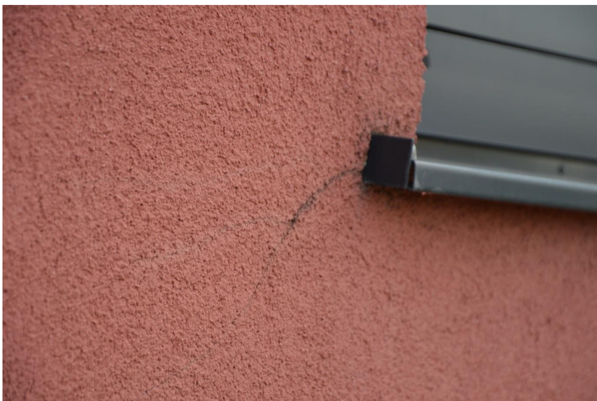
Rys. nr 45. Zarysowanie na powierzchni tynku cienkowarstwowego ETICS odchodzące od narożnika okna w pasie loggiowym elewacji NW. Brak oddylatowania obróbki podokiennika od ocieplenia ETICS w ościeżu [1.2.].
