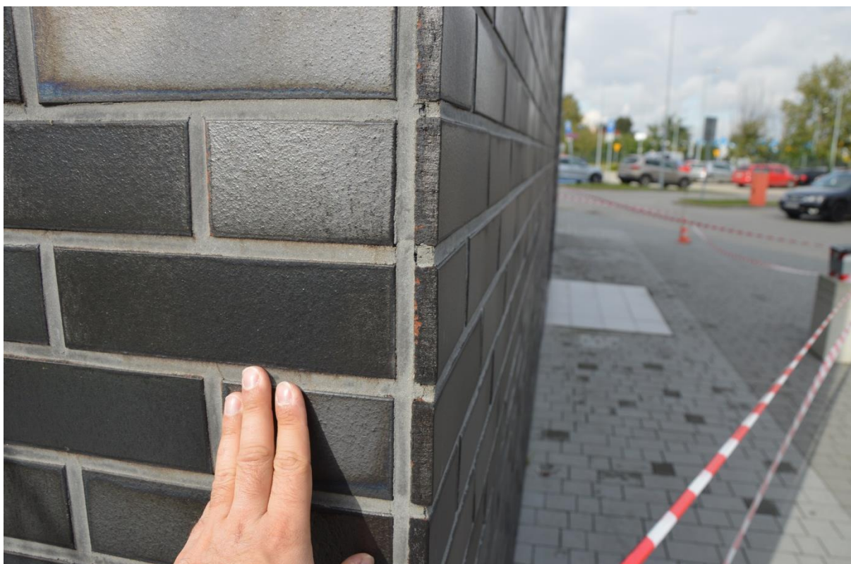
Rys. nr 18. Narożnik wypukły wykonany niezgodnie z wytycznymi systemu INFATEC oraz niezgodnie z wytycznymi dokumentacji projektowej (brak narożnych kształtek klinkierowych), obserwacja podczas wizji lokalnej [1.2].
