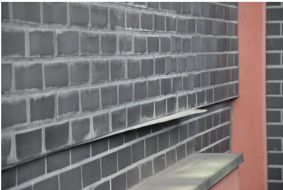
Rys. nr 41. Znaczące wysunięcie listwy startowej systemu INFATEC w obrębie zejścia piwnicznego na elewacji SE – nieprawidłowość oznaczona na mapie uszkodzeń jako B21 [1.2].
