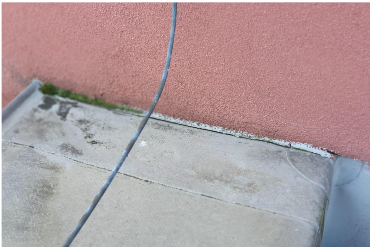
Rys. nr 52. Brak właściwej obróbki na połączeniu attyki z ociepleniem ETICS wykuszu klatki schodowej [1.2].
